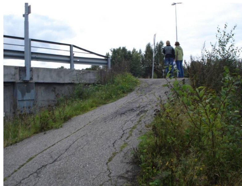
Strakstiltak 2: utbedring av rampe under rampe fra E6 nord. Nytt dekke, større bredde og mindre stiging
