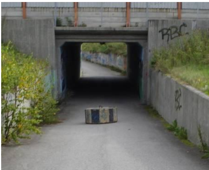
Strakstiltak 1: Betongsperrer erstattes med bom (sykkelsperre). Bedre belysning.
