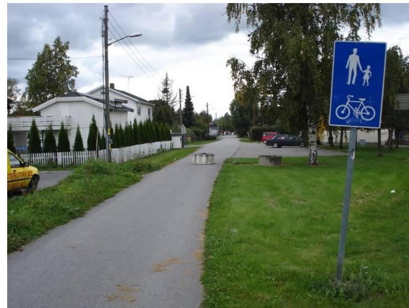
Figur 4-9: Stasjonsvegen. Forslag til strakstiltak er å erstatte sykkelperre med betongperre.
