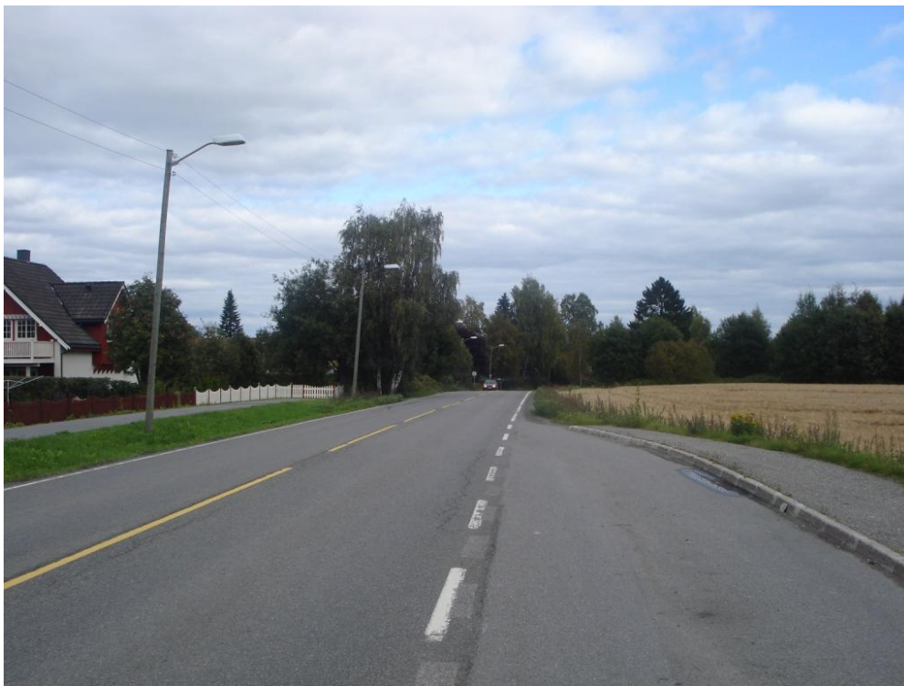
Trondheimsvegen lengst sør. Delstrekning med gang- og sykkelveg.
