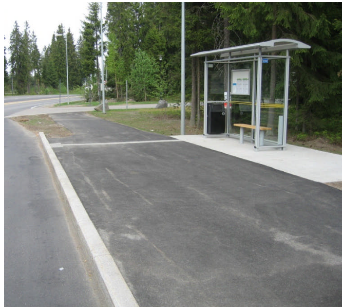
Nyanlagt holdeplass ved Henrik Ibsens veg
