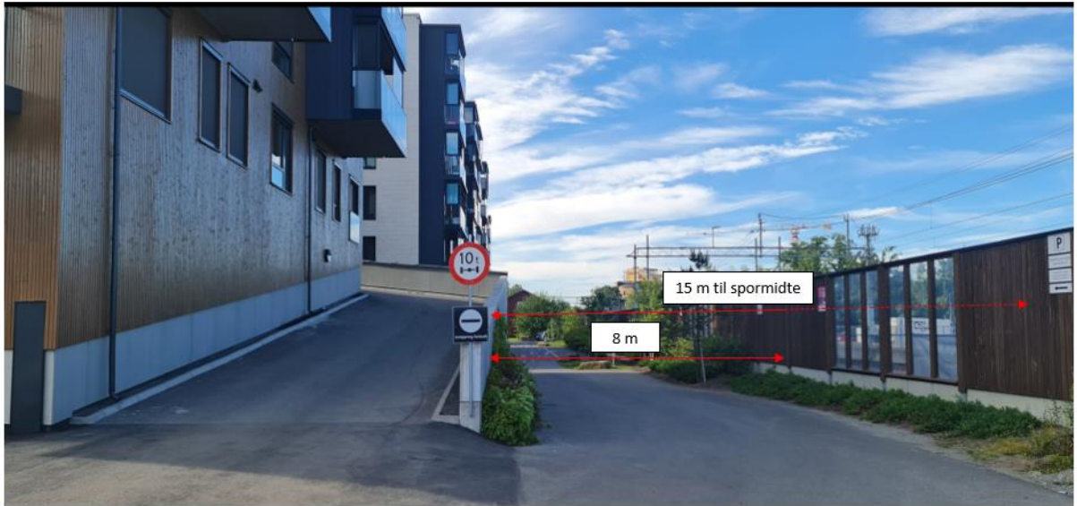
Eksisterende rampe – sett fra actiongata i retning mot sør
