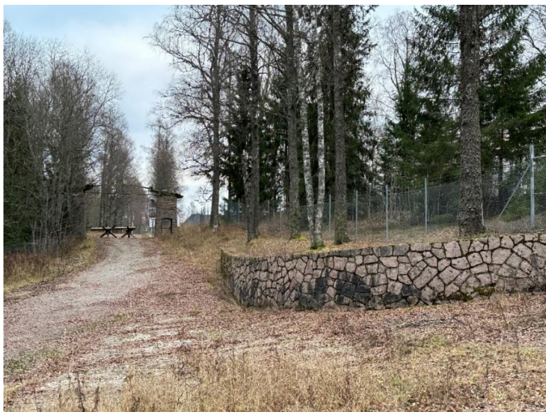
Figur 6; Den gamle hovedporten i nord bygd av tyskerne (markert A på flyfoto ovenfor)
