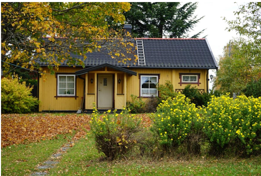
Sørbakk, ei godt bevart husmannsstue på Mogreina. Foto: Ullensaker kommune
