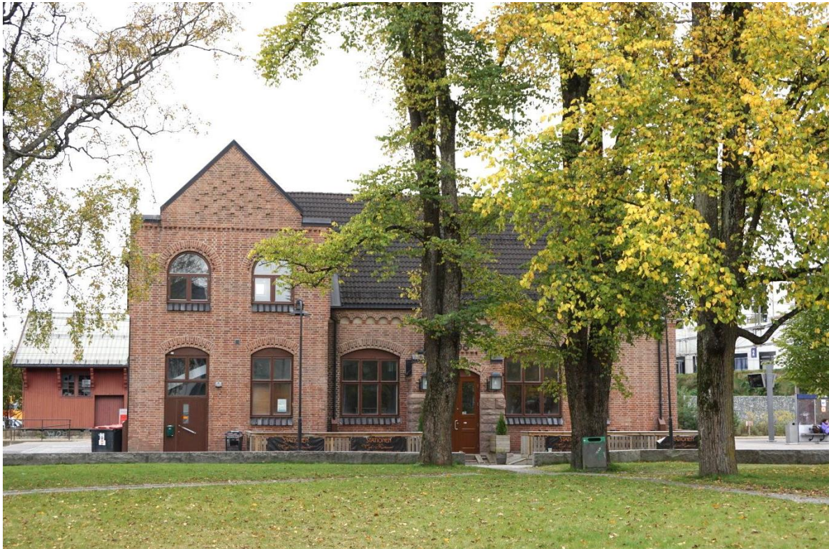
Fredete Jessheim stasjon, tegnet av arkitekt Henrik Bull og oppført i 1908. Pakkhuset fra 1857 i bakgrunnen. Foto: Ullensaker kommune
