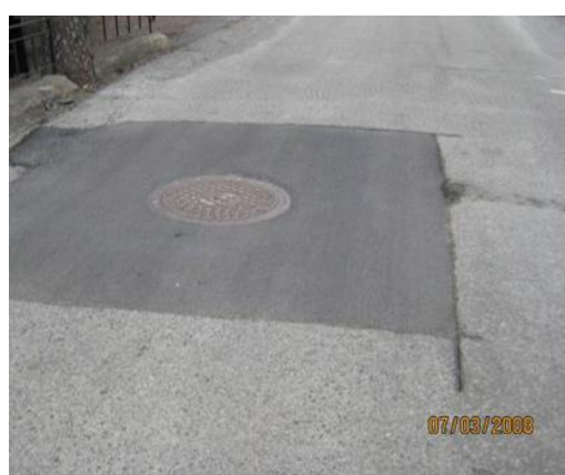
Eksempler på feil (bilde til venstre) og riktig utførelse (bilde til høyre) av skjæring av asfalt rundt kummer.
