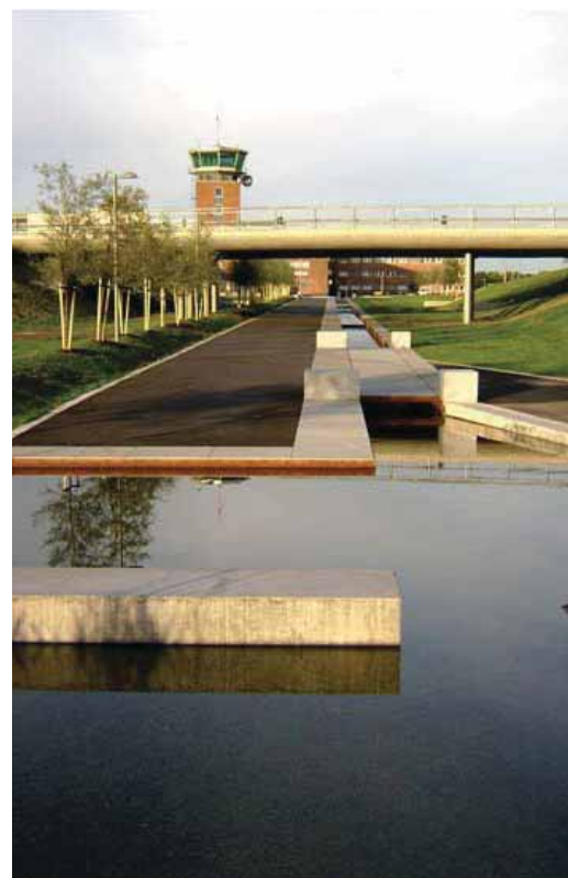
Flyplasstrasformasjon på Fornebu - Bjørbekk og Lindheim
