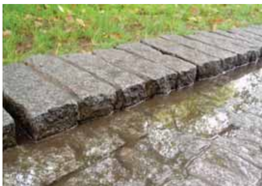
Overganger fra tette flater til grøntarealer som sikrer vanntransport og infiltrasjon.
