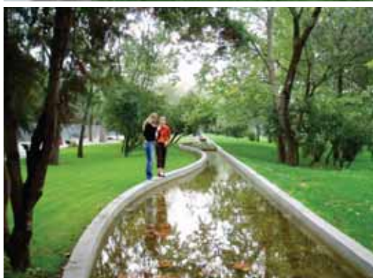
Renner for oppsamling og transport av overvann
