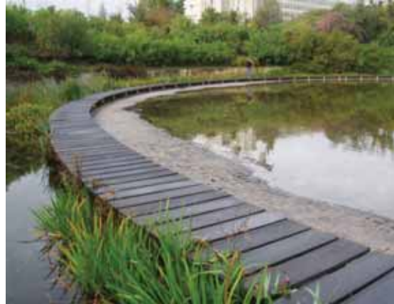
Åpen dam /"grytehullssjø": Overgang mellom permanent og temporær vannflate. Randsone med elvestein.
