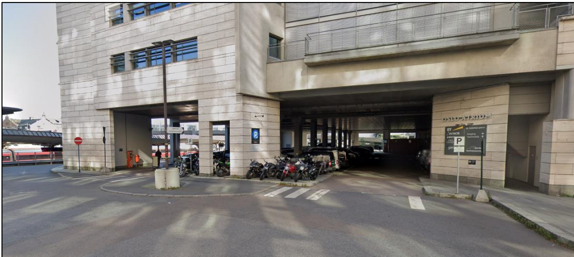
Figur 6.13: Korttidsparkering ved Oslo sentralstasjon (Kilde: Google Maps street view).
