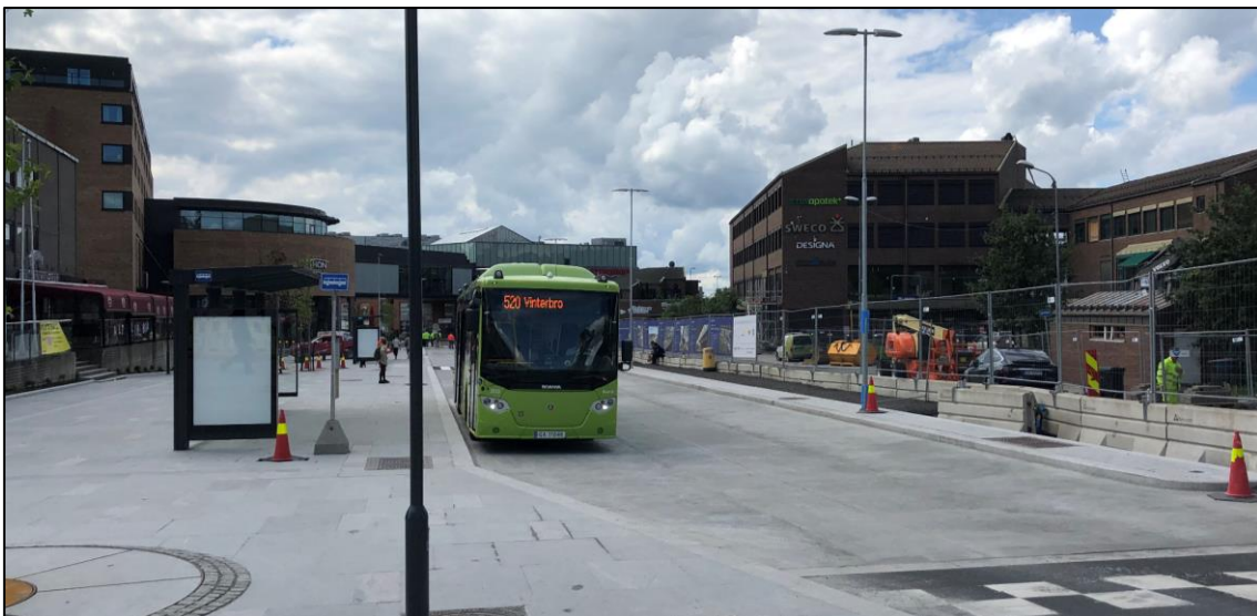
Figur 6.14: Gateterminal ved Ski stasjon som er under utbygging (bilde fra 9. juni 2020). Bare halvparten av terminalen (den østre delen) fram til midtdeler er ferdig etablert. (fotokilde: Sweco).
